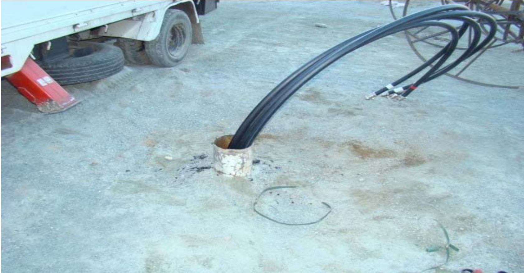
Газрын гүн дэх хөрсний дулааныг дамжуулах хоолойг угсрах шуудууг ухсан байдал
