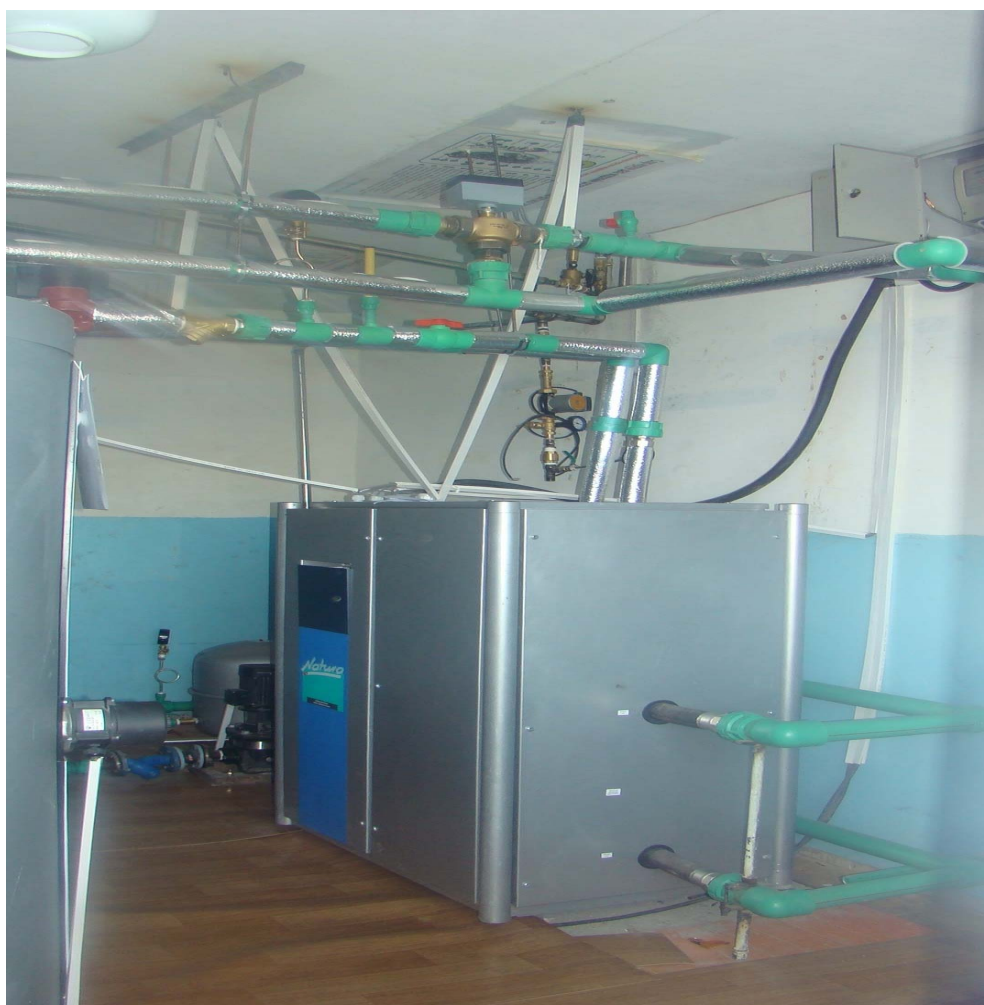
Халуун усны танкуудыг техникийн өрөөнд угсарсан байгаа байдал
