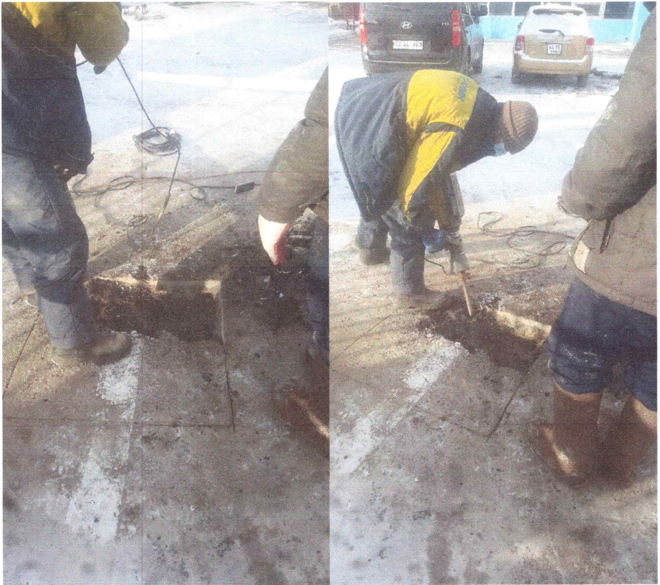
Зураг 2. Суурийн нүх ухаж байгаа байдал
