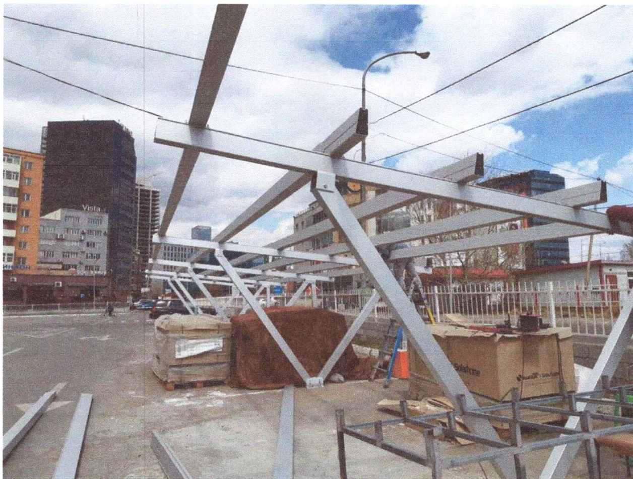
Зураг 13. Нарны эх үүсвэртэй 12 авто машины зогсоолын суурилуулалт
