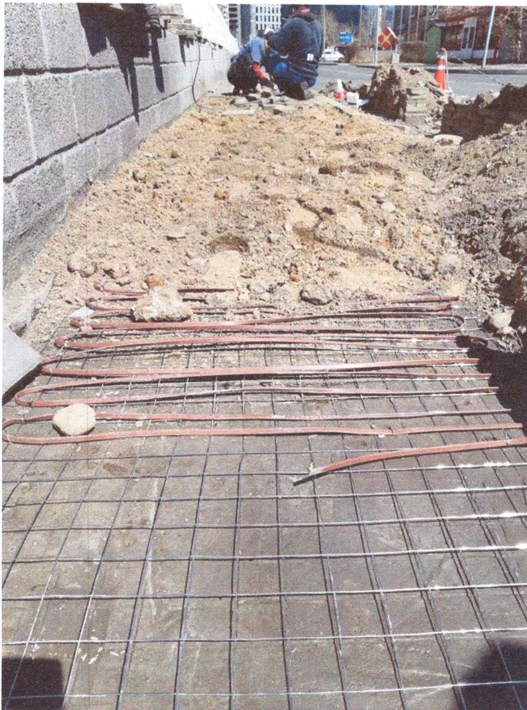
Зураг 34. Халаагч дээр шороон үе үүсгэж, явган замын хавтан суурилуулж байна.
