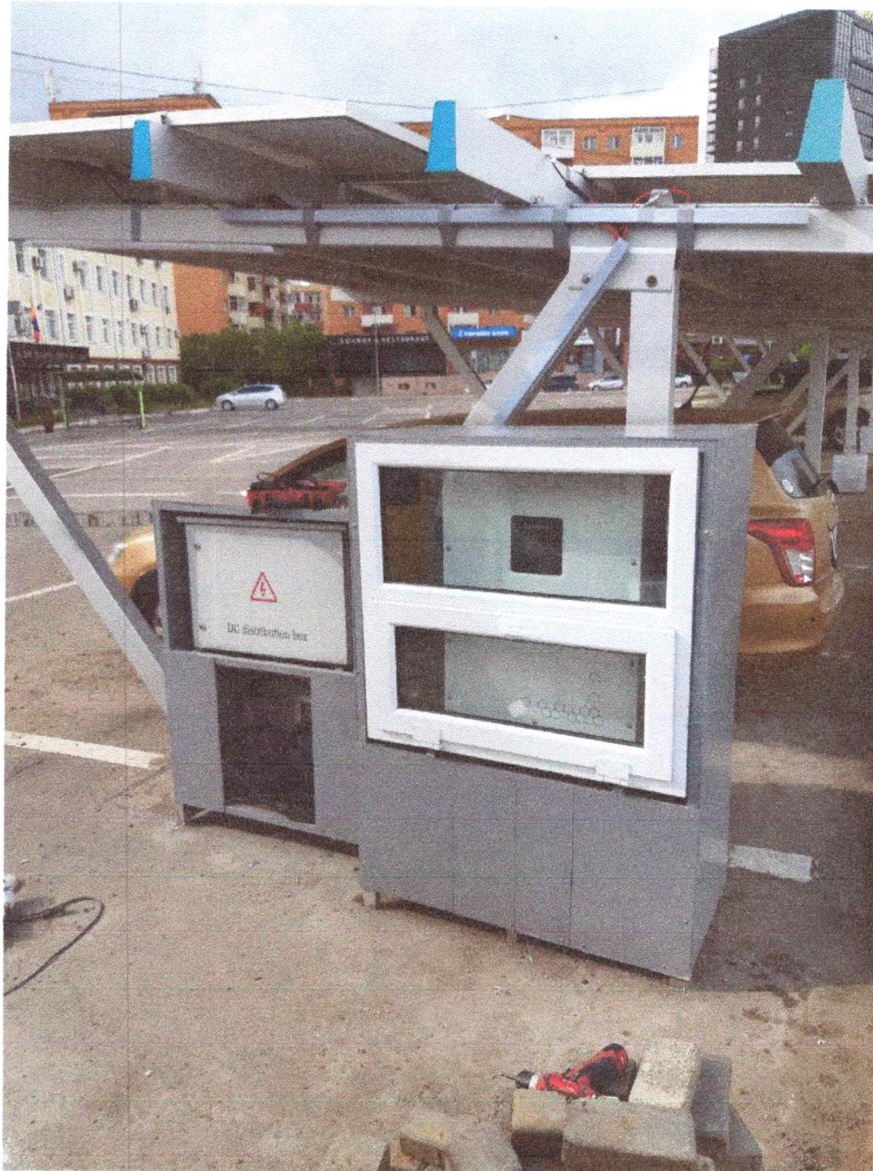
Зураг 37. Шитний хайрцагны кабелийн далд монтаж хийгдсэн байдал.
