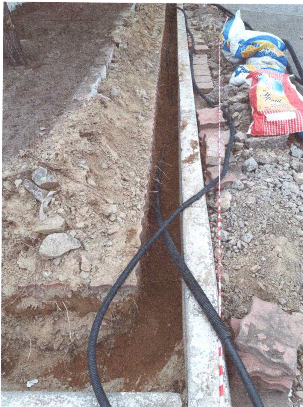
Зураг 22. Нүхэнд элс асган 380В кабелийг байршуулсан
