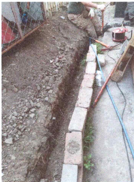
Зураг 21. Кабелийн нүх ухсан байдал
