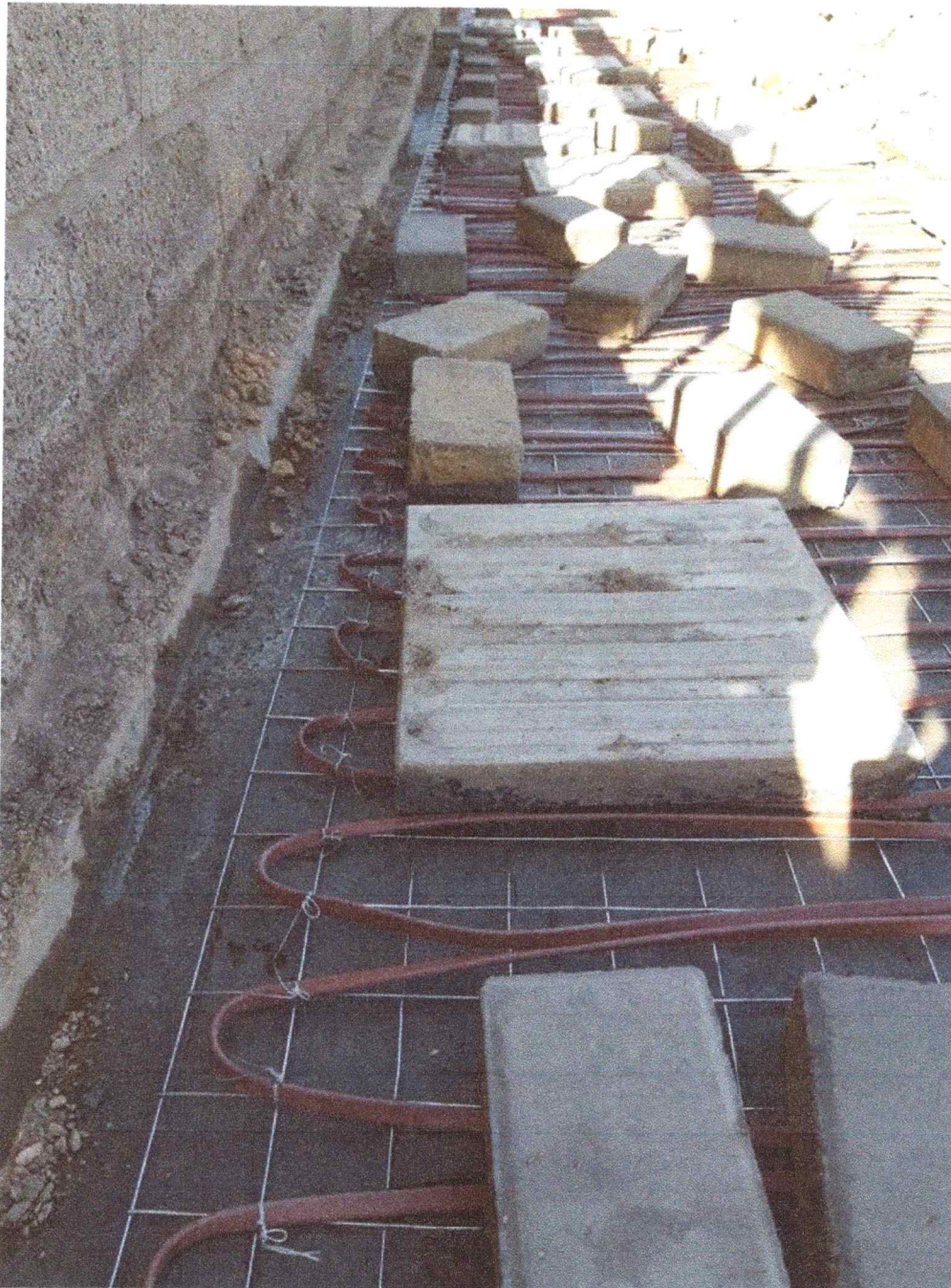
Зураг 32. Төмөр торон халаагчийг бетонд бэхэлж байна.
