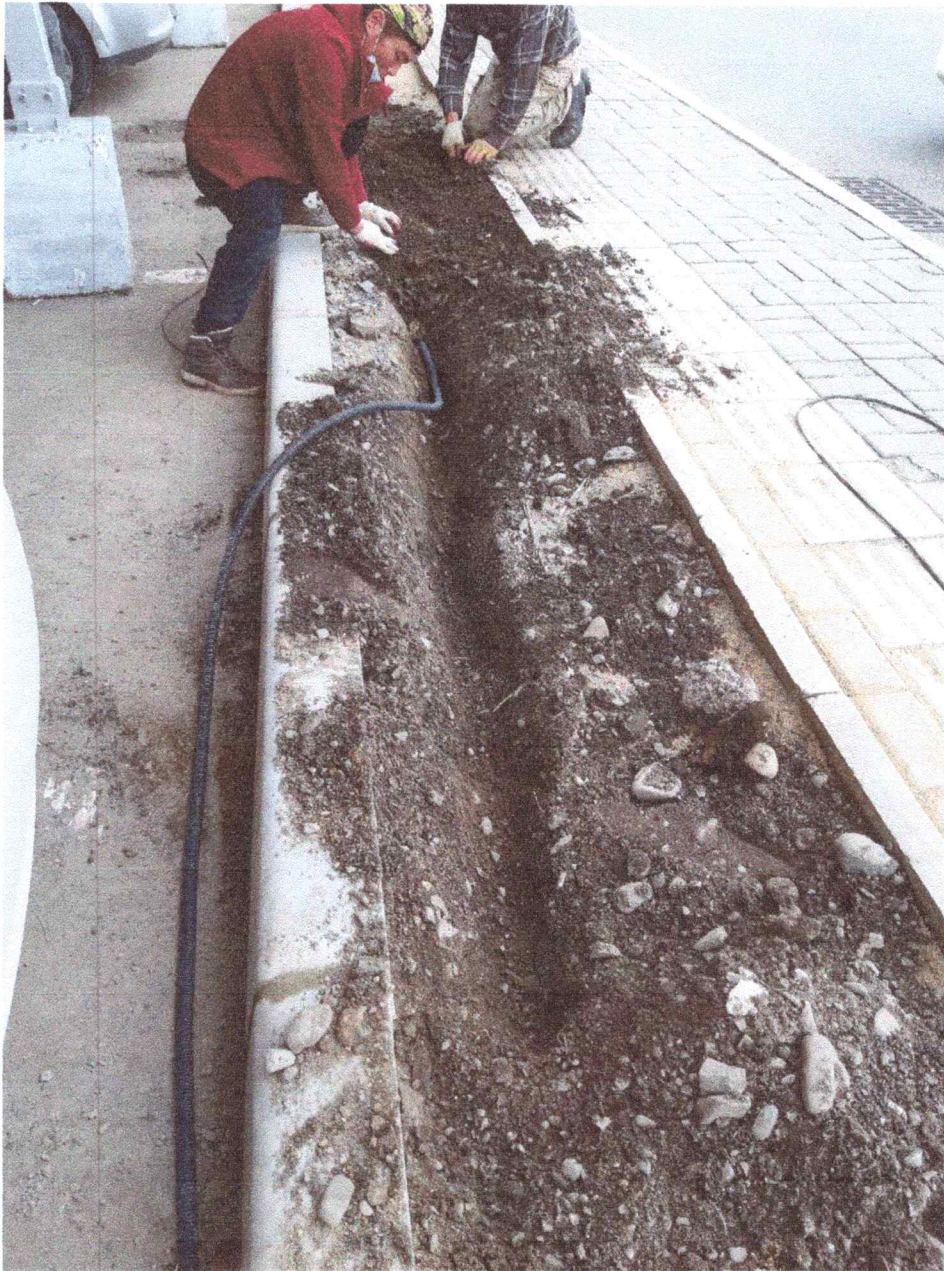
Зураг 36. Халаагч утасны тэжээлийн кабелийн далд монтаж
