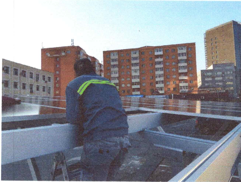
Зураг 15. Нарны эх үүсвэрийг суурилуулж байгаа байдал
