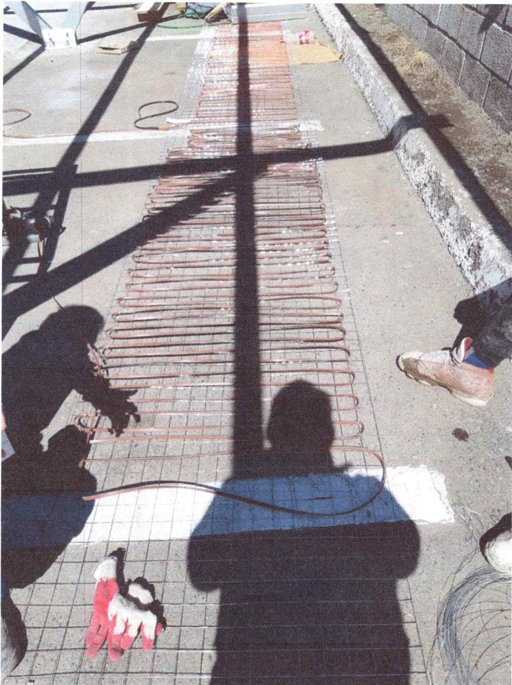
Зураг 31. Халаагч утсыг төмөр торон бэхлэж байна
