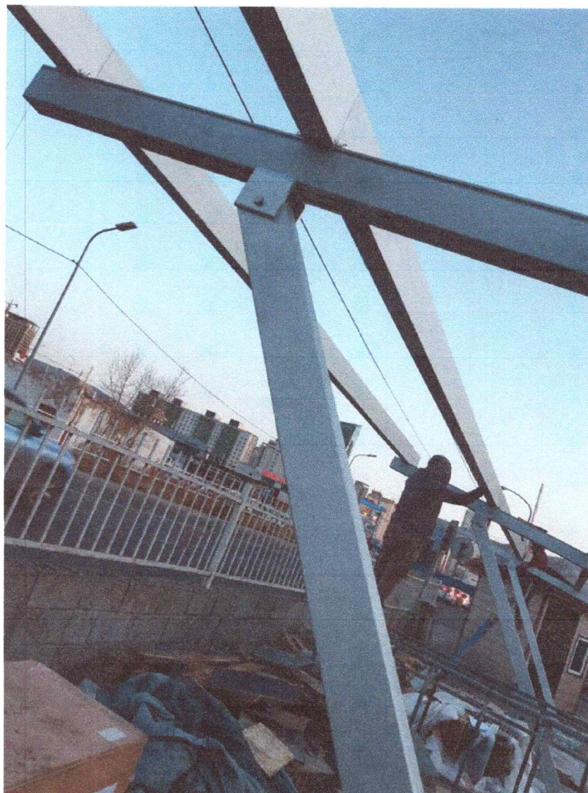
Зураг 11. Дан нурууг суурилуулж байгаа байдал.
