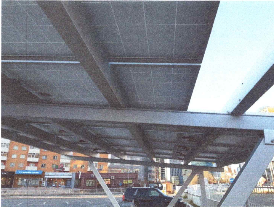
Зураг 15. Нарны эх үүсвэр суурилуулж байна.
