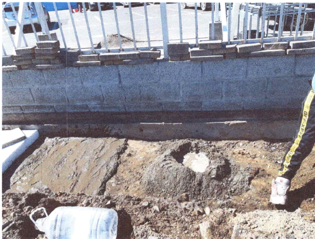
Зураг 18. Доод бетон давхарга хийж байна.
