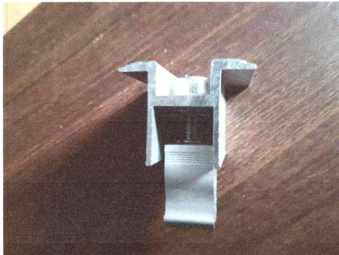
Зураг 15. Нарны хавтанг суурилуулах зориулалтын деталь
