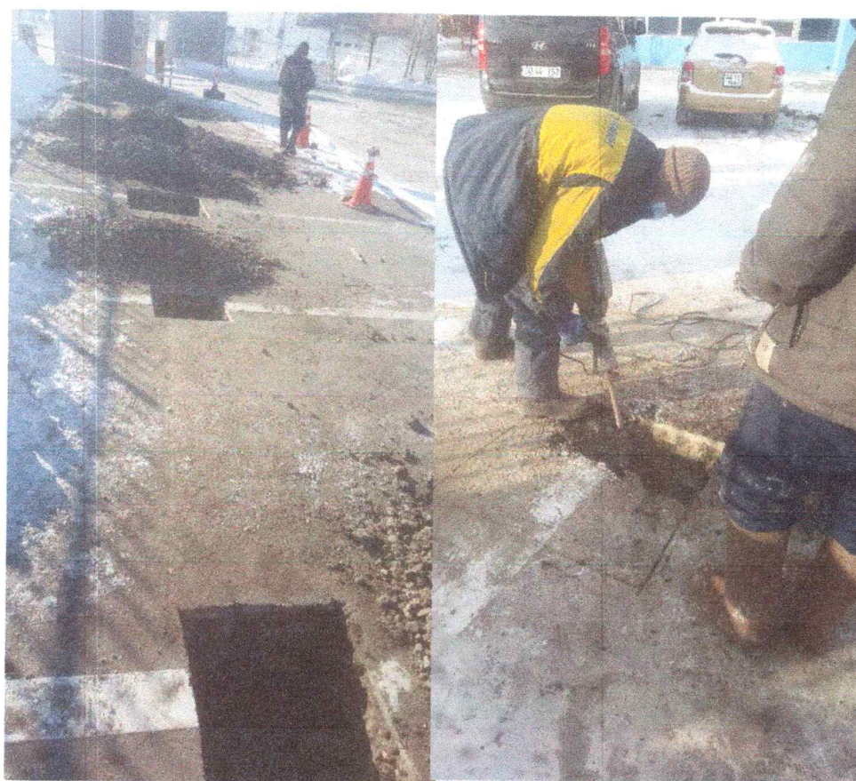
Зураг 7. Суурийн нүх ухааж байгаа байдал
