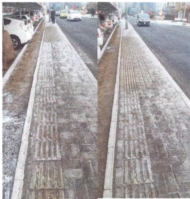
Зураг 23. 2022 оын 12 сарын 25 –ны өдрийн хэмжилт, Явган зам дээр унаж байгаа цас тогтохгүй хайлж байгаа байдал
