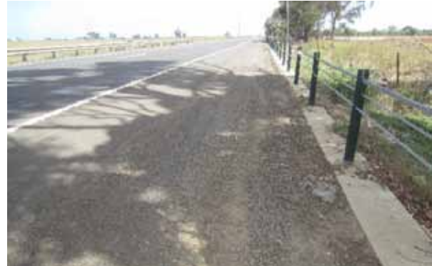
Уян хаалт нь хүчтэй цохилт ирэх үед их хэмжээгээр хазайж нумран буцаж хэвэндээ ордог. Хаалтыг замын хажуугийн зайнд байрлуулахдаа зөвшөөрөгдсөн зайнд аюулаас хол байхаар төсөллөх хэрэгтэй.
