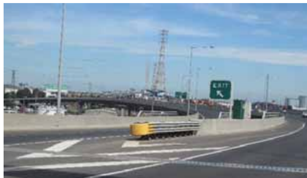
Хүч сулруулагч нь хязгаарлагдмал байршлууд дээр хөшүүн хаалтын төгсгөлийг хаахад маш сайн тохирно.
