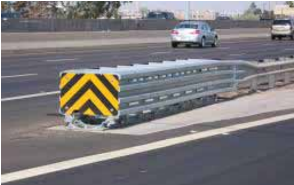
Хүч сулруулагч хэд хэдэн төрөл байдаг. Зөвхөн батлагдсан төрлийг нь ашиглах хэрэгтэй.
