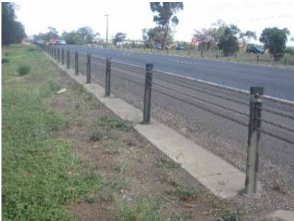
Уян хатан хаалтууд (троссон аюулгүйн хаалт) нь аюулгүй төрлийн хаалтад багтах нь нотлогдсон. Эдгээрийг мөргөсөн тохиолдолд 2 м (эсвэл үүнээс илүү) сунах боломжтой байдаг.
