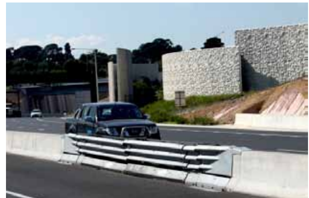
Яаралтай тусламжийн үед эдгээр гарцыг нээхэд эрх бүхий хүн эргүүл хийж зохицуулах бөгөөд замын хөдөлгөөн нэг зорчих хэсгээс нөгөө зорчих хэсэг хүртэл аюулгүй өнгөрөх боломжтой. Бусад цагт энэ нь хаалттай байх ёстой.
