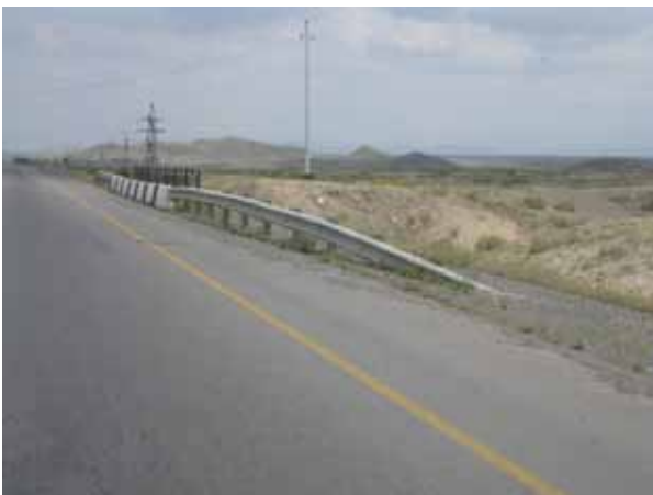
Нэг чиглэлтэй зам дээрх хаалтын туслах төгсгөлөөс гадна КАРЕК-ийн хурдны замуудын өндөр хурдны хэсэгт үүн шиг налуу төгсгөлийг ашиглахгүй байх хэрэгтэй.
