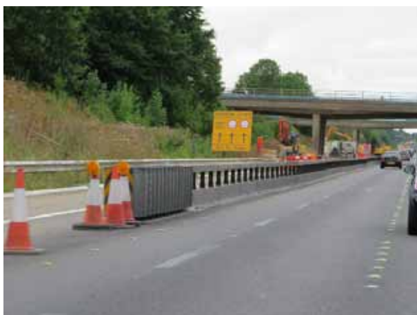
Зарим мөргөлтийн хүч сулруулагч нь авто замын барилгын ажлын талбай дахь нарийн/хавчиг талбайд ашиглахад зориулагдсан байдаг.
