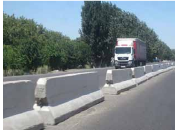
Иймэрхүү салангид бетон хаалтууд нь дүрэм зөрчиж буцаж эргэх үйлдэл гаргахаас сэргийлэх хэдий ч эдгээр нь аюултай бөгөөд ялангуяа тээврийн хэрэгсэл уг хаалтны ил гарсан төгсгөл хэсгийг мөргөх тохиолдолд илүү аюултай байна.
