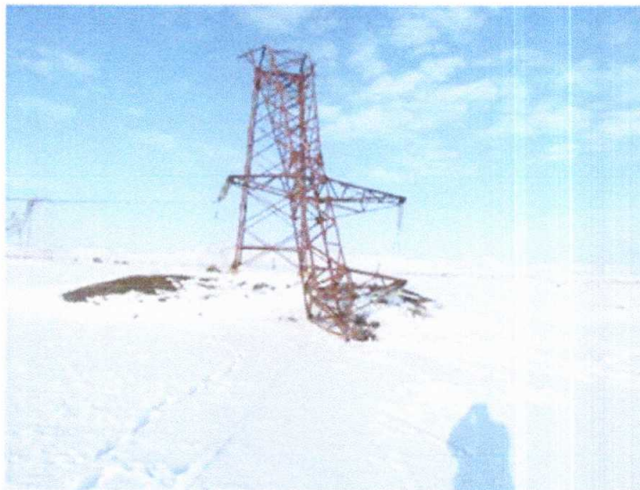
Зураг 3.7. 2011 онд Даран уул аймаг, Сэлэнгэ аймагт болсон хүчтэй шороон шуурга, мөстлөгийн улмаас 220/110 кВ-ын шугамын тулгуурууд хазайж унасан байдал
