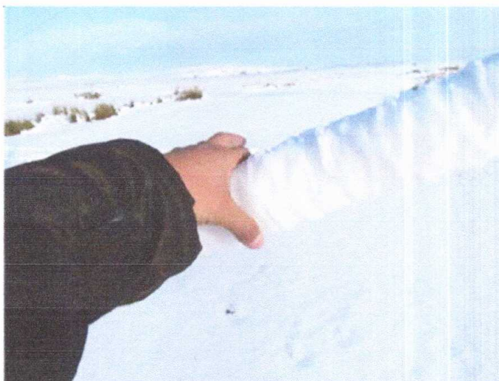
Зураг 3.8. 2011 онд Даран уул аймаг, Сэлэнгэ аймагт болсон хүчтэй шороон шуурга, мөстлөгийн улмаас 220/110 кВ-ын шугамын дамжуулагч утас зузаан цас, мөсөөр хучигдсан байдал
