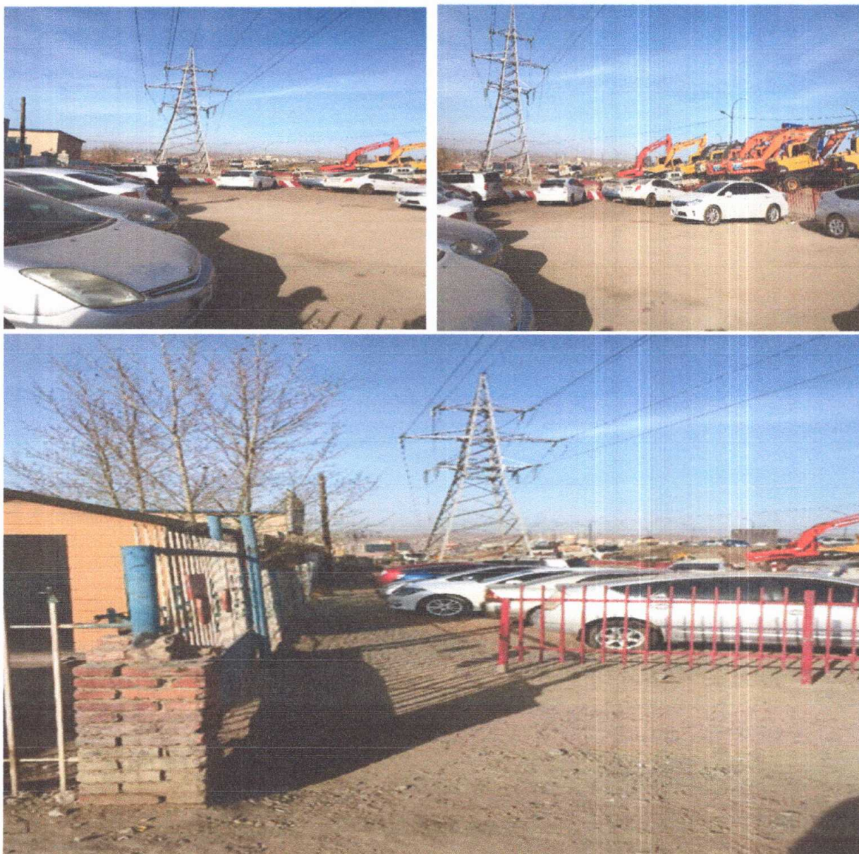
Зураг 20. Улаанбаатар салбар 110/10/6 Үйлдвэр дэд станц
