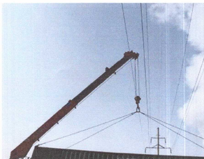
Зураг 4.5. Автокран 111-р шугамын дамжуулагч утасны доор контейнер өргөсөн байдал.
