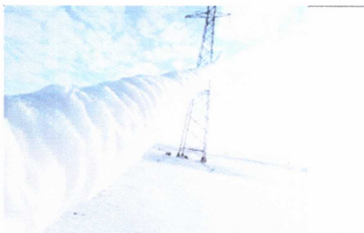
Зураг 3.9. 2011 онд Даран уул аймаг, Сэлэнгэ аймагт болсон хүчтэй шороон шуурга, мөстлөгийн улмаас 220/110 кВ-ын шугамын дамжуулагч утас зузаан цас, мөсөөр хучигдсан байдал
