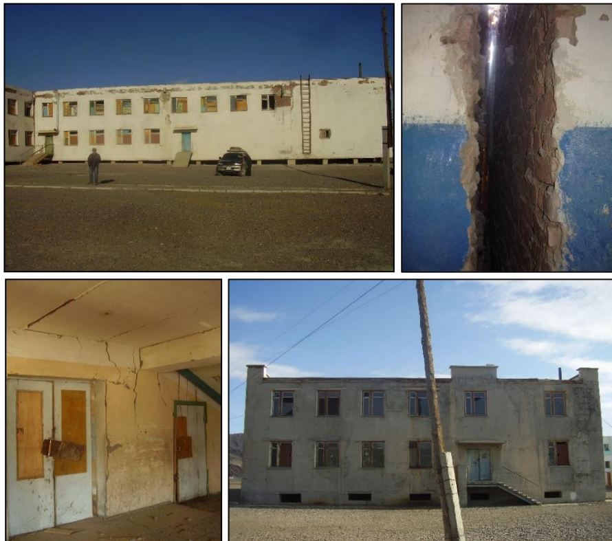
Хавсралт 2. Баян-Өлгийн аймаг Цагааннуур тосгоны барилгын хананд үүссэн хагарал.
