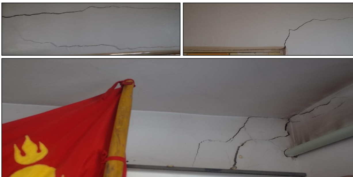
Хэвсралт 5. Архангай аймгийн Цахир сумын захиргааны барилгын хана, таазанд үүссэн хагарал, цууралт.
