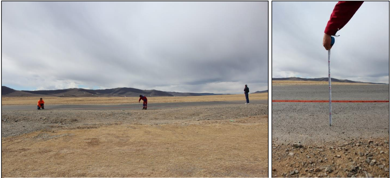
Хавсралт 7. Цэвдгийн гэсэлтээс болж суулт өгч буй авто зам. Чулуут голын хөндий.
