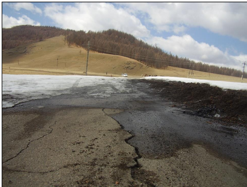
Хавсралт 8. Тэрэлж орчим үүссэн халиа зам давж авто тээврийн хөдөлгөөнд аюул учруулж буй байдал.
