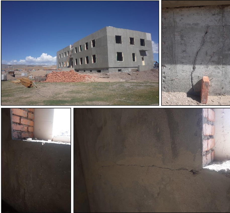
Хавсралт 3. Архангай аймгийн Цахир суманд шинээр баригдаж буй сургуулийн хана болон, сууринд үүссэн хагарал, цууралт.
