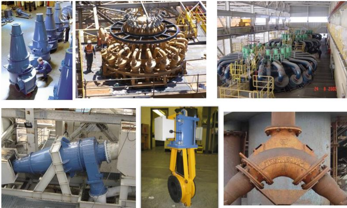
Зураг 101. Гидроциклоны суурилуулалт
