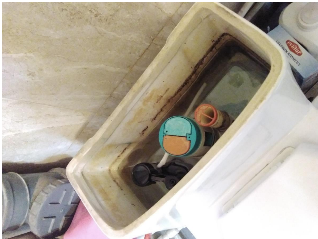
Зураг 47: СБД-д байрлах орон сууцны суултуурын дотор тал зэвэрсэн байдал
