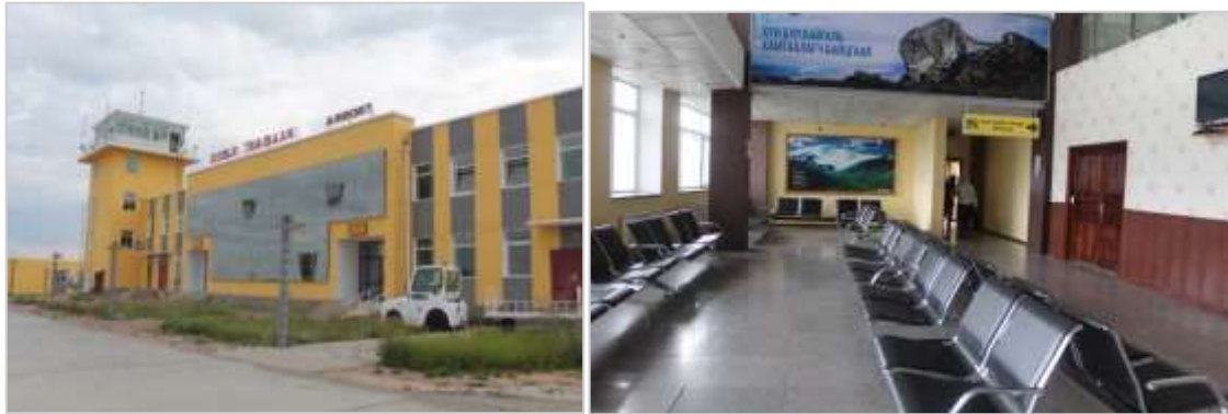
Зураг 2.5. Аэровокзалын төв барилга болон зорчигч үйлчилгээний танхим
