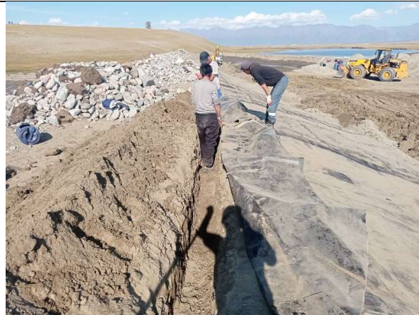
Зураг 6: Урсгал чиглүүлэх далан /ПК0+00 – ПК1+68/-ийн дээд налууд ус тусгаарлах материалын бэхэлгээний шуудуу ухсан байдал
