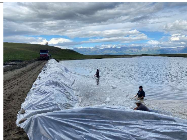
Зураг 5: Барилгын ажлын үеийн түр далангийн дээд налууд ус тусгаарлах гялгар материал /t=5 мм/ хийж буй байдал
