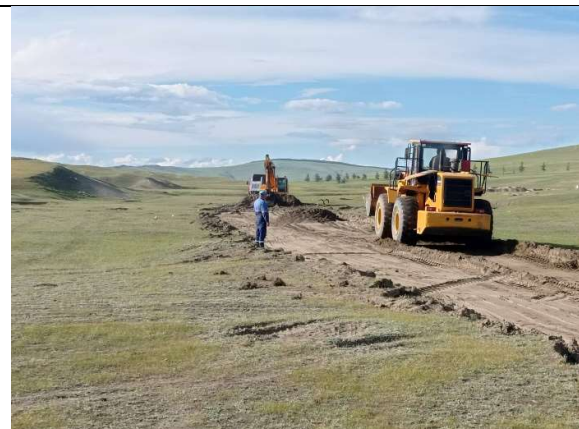
Зураг 5: Ходон голын үндсэн голдиролд холбох суваг-1-ийн шуудууны ёроолын тэгшилгээ хийж буй байдал
