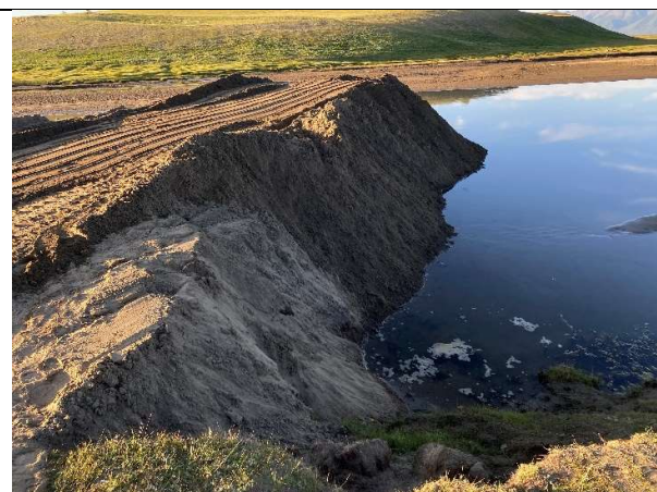
Зураг 1: Барилгын ажлын үеийн түр далангийн овоолгын ажил хийгдэж буй байдал
