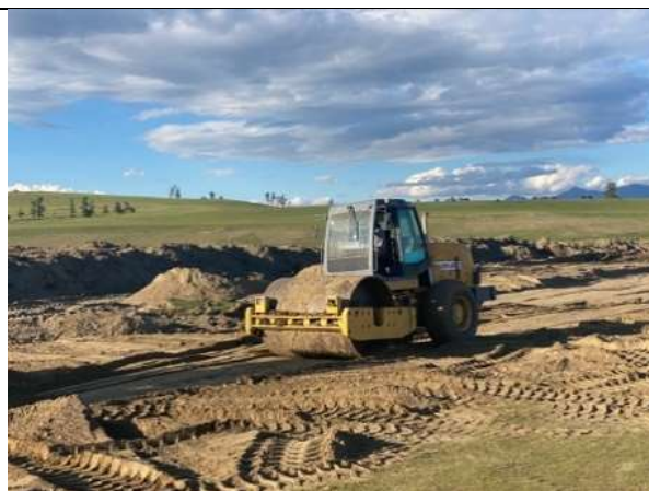
Зураг 8: Ходон голын үндсэн голдиролд холбох суваг-2-ын ёроолын нягтруулга хийж буй байдал
