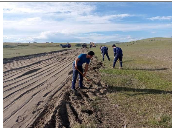
Зураг 6: Ходон голын үндсэн голдиролд холбох суваг-1-ийн шуудууны ёроолын тэгшилгээ хийж буй байдал
