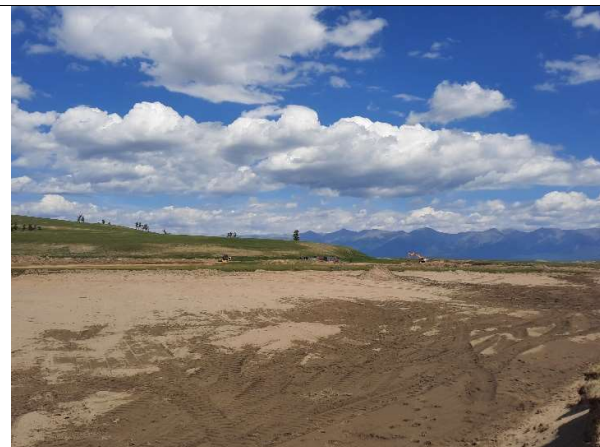
Зураг 11: Ходон голын үндсэн голдиролд холбох суваг-2-ын ухлага хийгдсэн байдал, b=120 м
