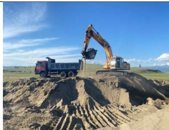
Зураг 2: Ходон голын үндсэн голдиролд холбох суваг-1-ийн шуудууны ухлага хийж буй байдал
