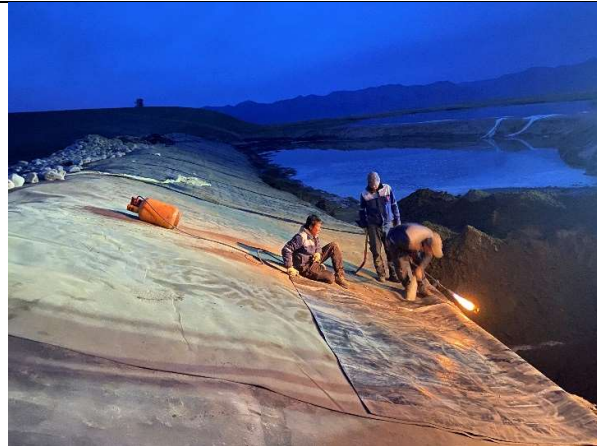
Зураг 5: Урсгал чиглүүлэх далан /ПК0+00 – ПК1+68/-ийн дээд налууд ус тусгаарлах материал /t=1.5 мм/ 2 үе хийж буй байдал
