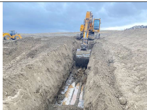
Зураг 7: Урсгал чиглүүлэх далангийн дээд хашицад шавар шүдний шуудуу ухсан байдал
