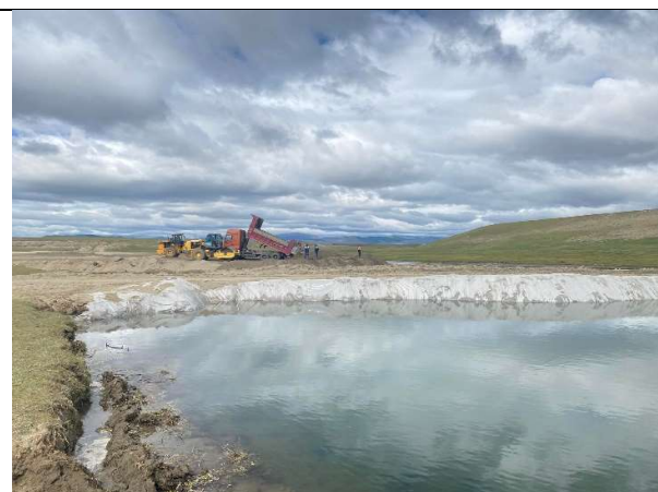
Зураг 9: Түр далагийн овоолго, нягтруулга, ус тусгаарлах материал хийгдсэн байдал
