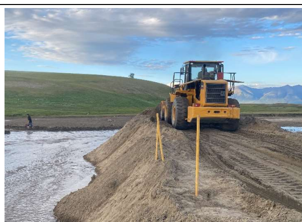
Зураг 2: Барилгын ажлын үеийн түр далангийн овоолгын ажил хийгдэж буй байдал
