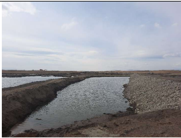
Зураг 12: Ходон голын урсгал чиглүүлэх далангийн дээд хашицын бэхэлгээний чулуу хийгдсэн байдал
