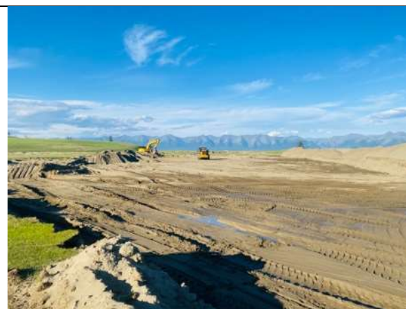
Зураг 5: Ходон голын үндсэн голдиролд холбох суваг-2-ын ёроолын тэгшилгээ хийж буй байдал
