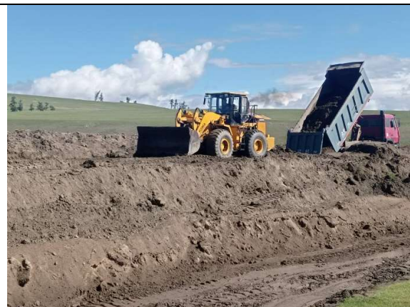
Зураг 2: Ходон голын үндсэн голдиролд холбох суваг-1-ийн шуудууны ухлага хийж буй байдал
