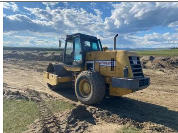
Зураг 9: Ходон голын үндсэн голдиролд холбох суваг-2-ын ёроолын нягтруулга хийж буй байдал
