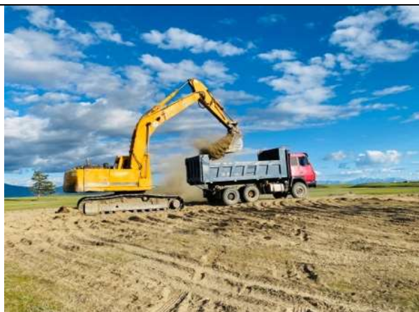
Зураг 4: Ходон голын үндсэн голдиролд холбох суваг-2-ын шуудууны ухлага хийж буй байдал
