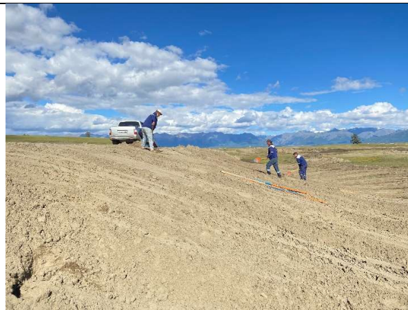
Зураг 4: Урсгал чиглүүлэх далангийн дээд хашицын налуугийн тэгшилгээ хийгдэж буй байдал
