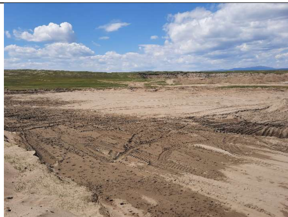
Зураг 10: Ходон голын үндсэн голдиролд холбох суваг-2-ын ухлага хийгдсэн байдал, b=120 м
