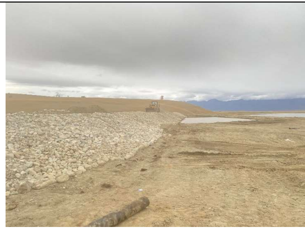
Зураг 11: Ходон голын урсгал чиглүүлэх далангийн дээд хашицын бэхэлгээний чулуу хийгдсэн байдал
