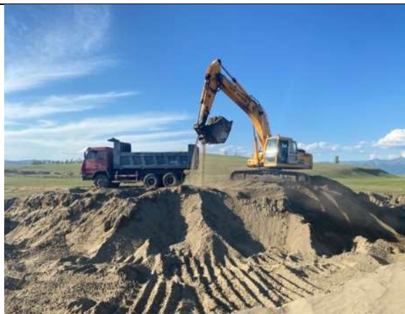
Зураг 2: Ходон голын үндсэн голдиролд холбох суваг-2-ын шуудууны ухлага хийж буй байдал
