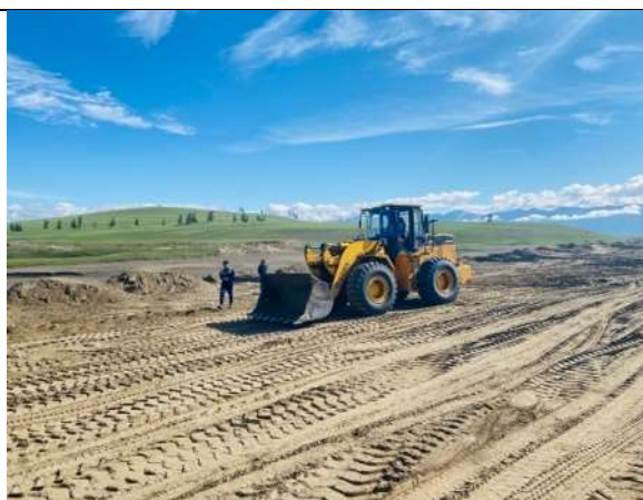
Зураг 6: Ходон голын үндсэн голдиролд холбох суваг-2-ын ёроолын тэгшилгээ хийж буй байдал
