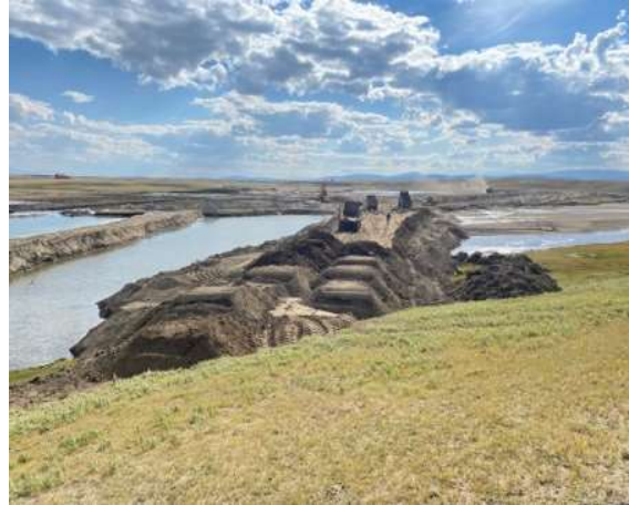
Зураг 1: Урсгал чиглүүлэх далангийн овоолго, нягтруулга хийгдэж буй байдал
