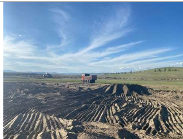
Зураг 1: Ходон голын үндсэн голдиролд холбох суваг-2-ын өнгөн хөрс хуулж буй байдал
