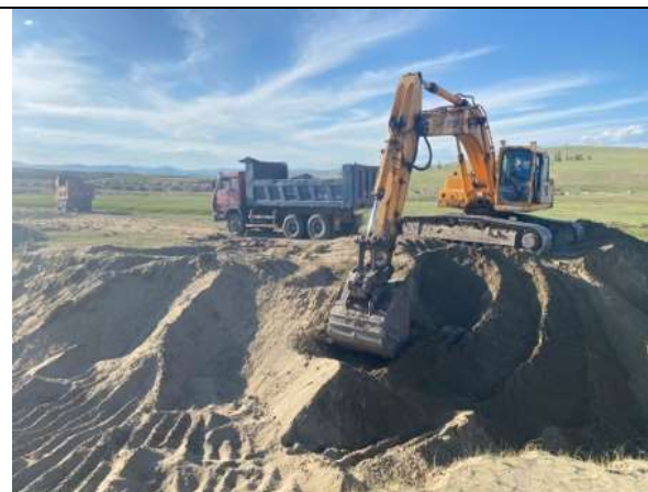
Зураг 3: Ходон голын үндсэн голдиролд холбох суваг-2-ын шуудууны ухлага хийж буй байдал
