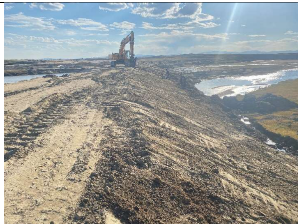
Зураг 3: Урсгал чиглүүлэх далангийн дээд хашицын налуугийн тэгшилгээ хийгдэж буй байдал
