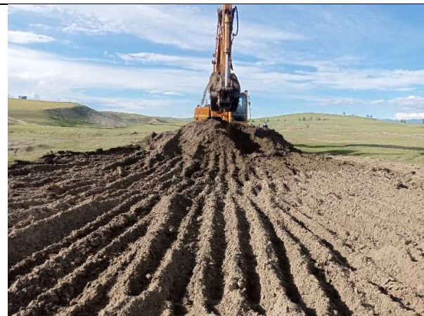
Зураг 1: Ходон голын үндсэн голдиролд холбох суваг-1-ийн өнгөн хөрс хуулж буй байдал
