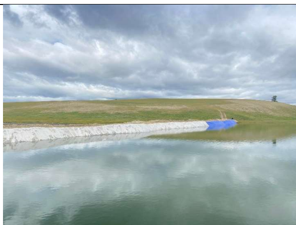
Зураг 10: Түр далагийн овоолго, нягтруулга, ус тусгаарлах материал хийгдсэн байдал
