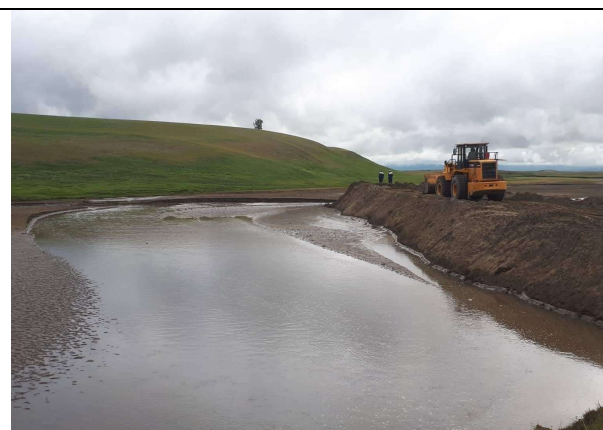
Зураг 1: Барилгын ажлын үеийн түр далангийн овоолгын ажил хийгдэж буй байдал
