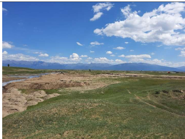
Зураг 12: Ходон голын үндсэн голдиролд холбох суваг-2-ын ухлага хийгдсэн байдал, b=120 м
