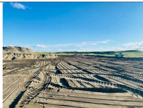
Зураг 7: Ходон голын үндсэн голдиролд холбох суваг-2-ын шуудууны ухлага хийж буй байдал
