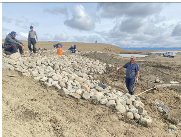
Зураг 8: Урсгал чиглүүлэх далангийн дээд хашицын налууд чулуун өрлөг хийж буй байдал
